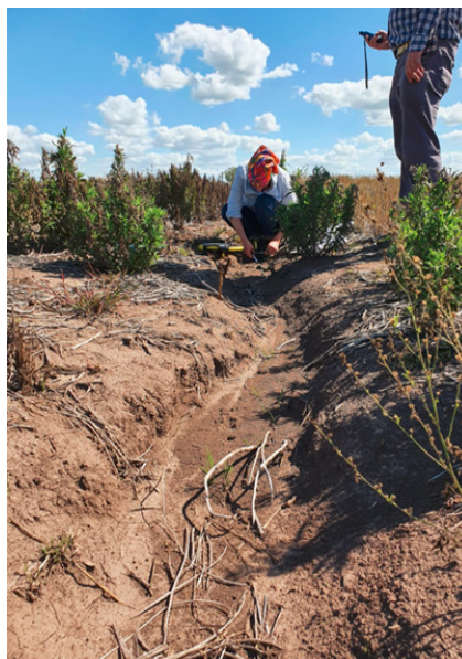
Figura 5: Material suelto y restos de cultivo arrastrados por el cauce de la cárcava. Figure 5: Loose material and crop residues transported across the gully.
